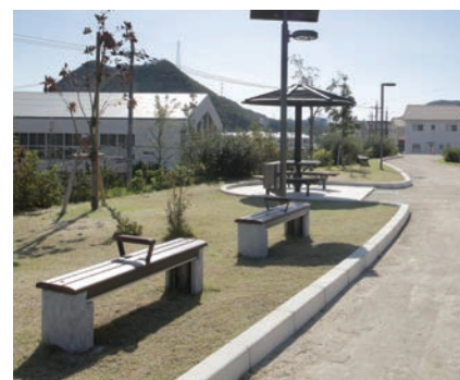
かまどベンチ。防災拠点としても機能している
